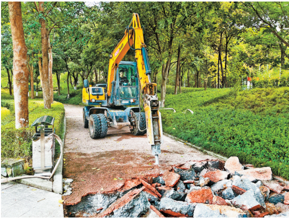
工程车对园内道路进行拆除。
