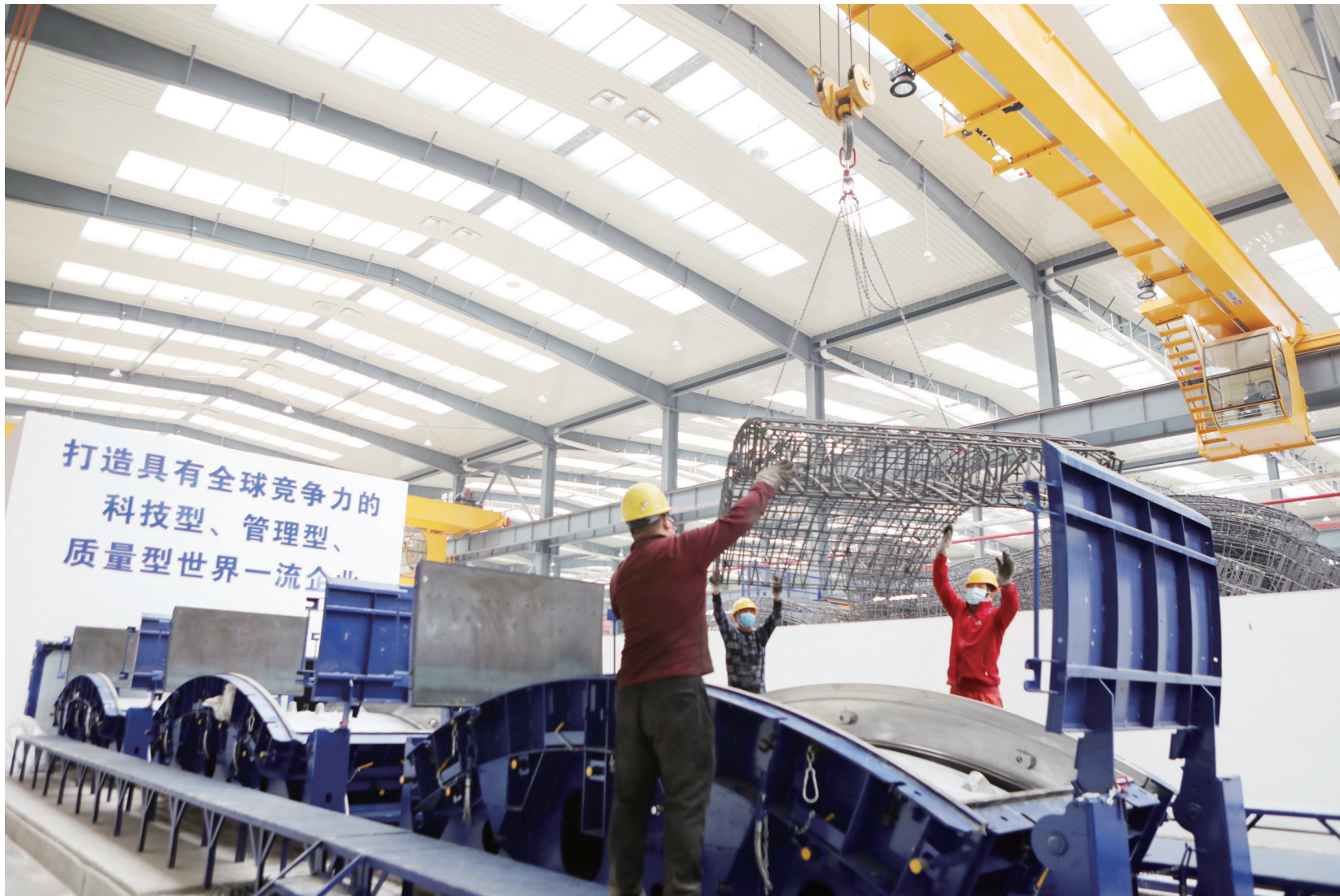
12月2日,工人在管片浇筑生产线上安装钢筋笼。
