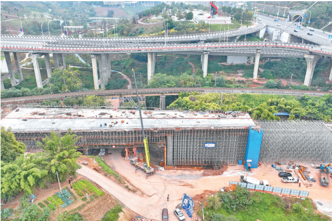
建设中的成渝铁路改造工程
