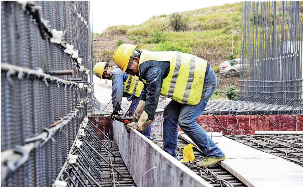
项目施工现场
