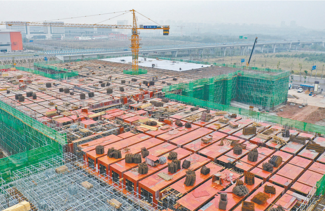
国通(西南)智慧冷链产业园建设现场。
