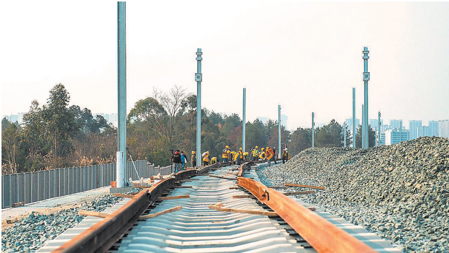
成自宜高铁成都段开始全面铺轨工作。
