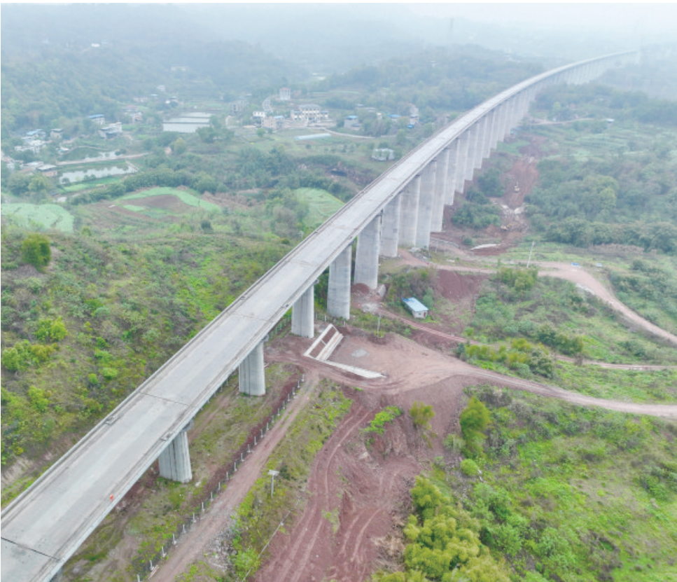
三百梯水库道岔特大桥已完成的部分架梁。
