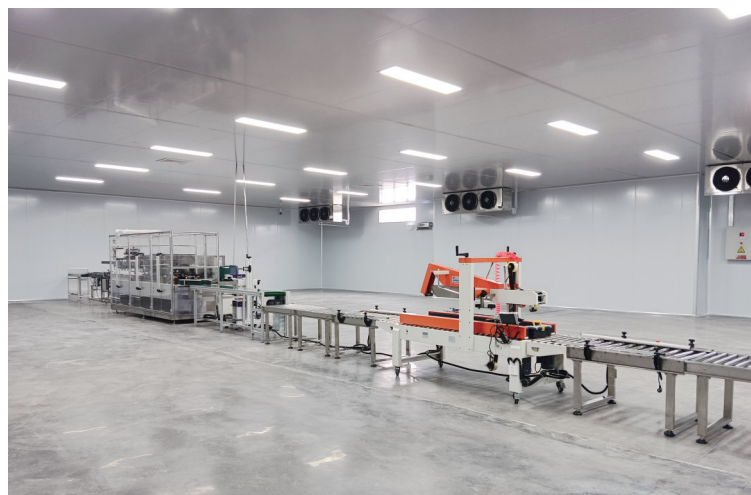
在幸福西饼生产车间设备已完成安装。
