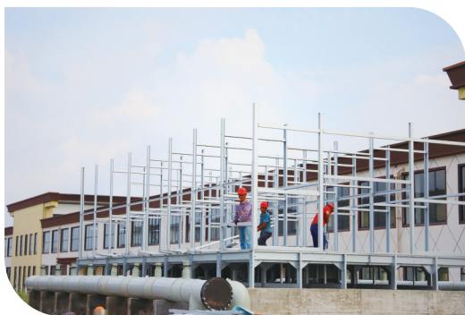
工人加紧安装二号冷却塔
