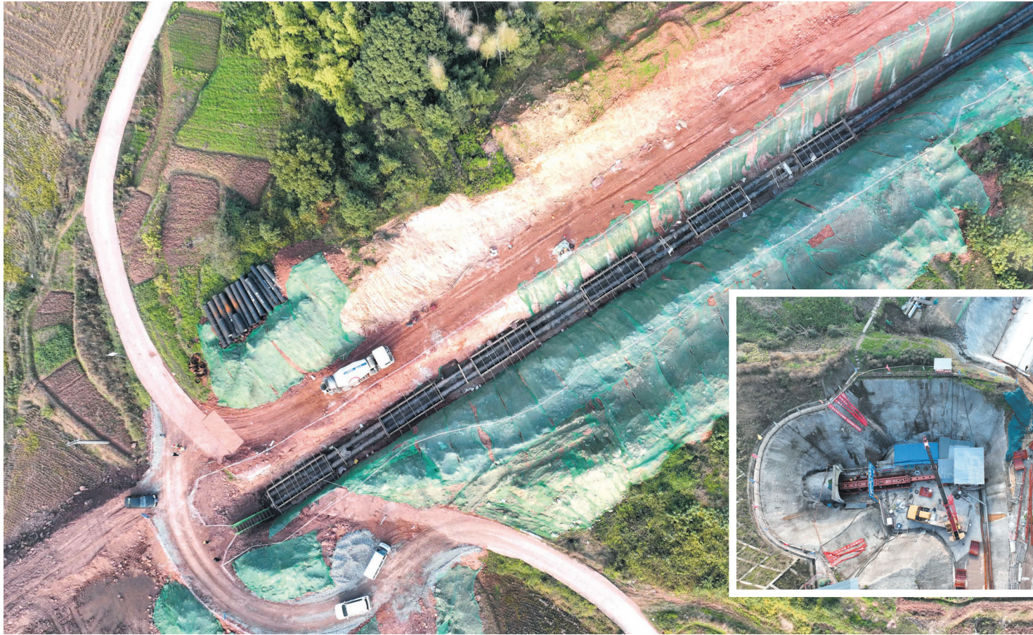
▲图为西干线输水线路三教水厂支线管线工程建设现场航拍图。
