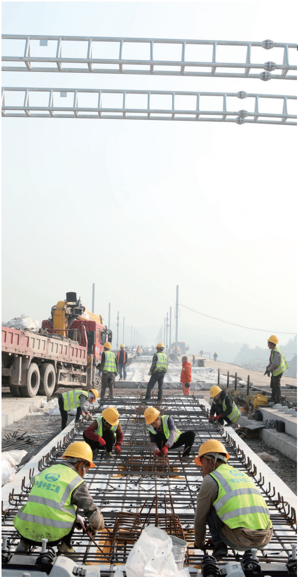
施工人员拼装扣件
