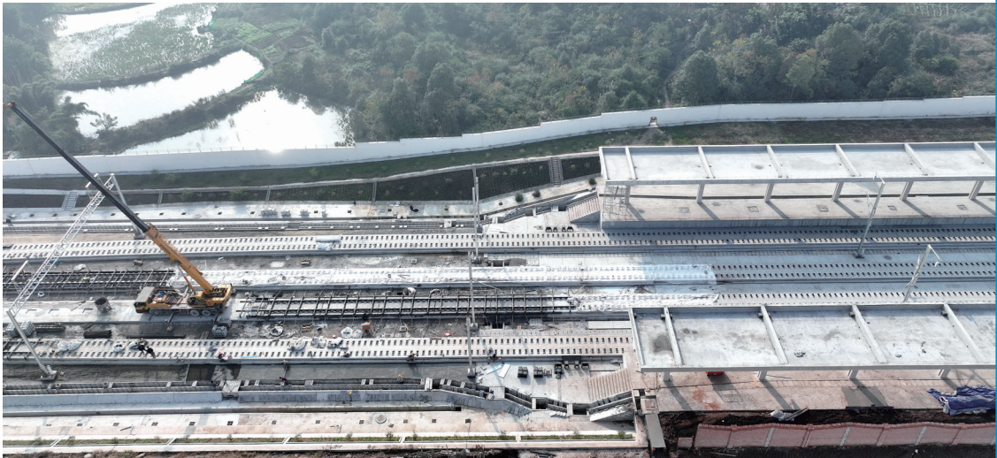
永川南站无砟轨道施工现场
