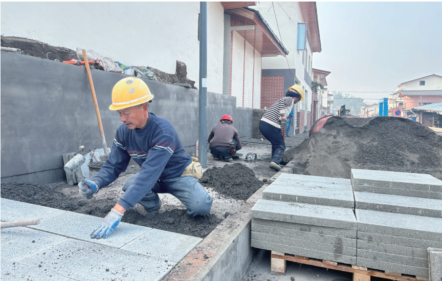
工人为人行道铺砖
