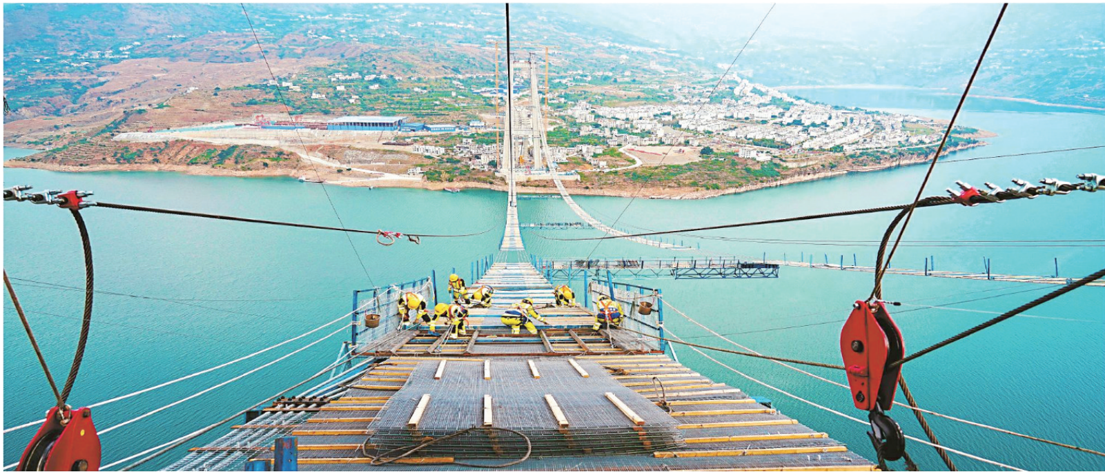
卡哈洛金沙江大桥迎新进展 首根主缆索股架设成功
