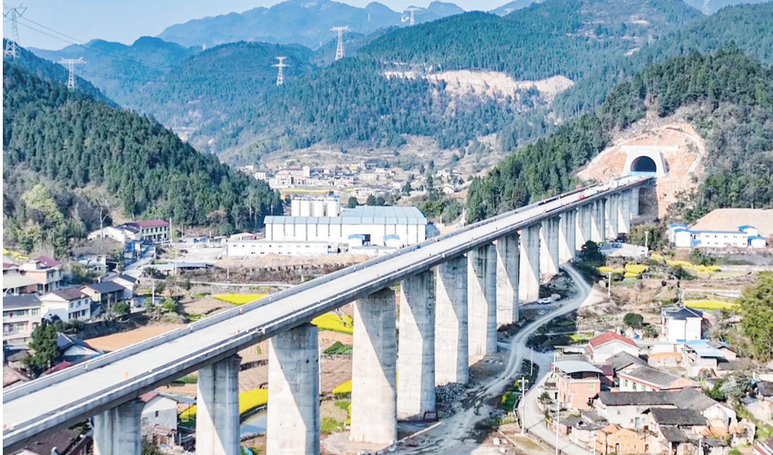
3月16日,渝湘高铁全线控制性工程楠竹山隧道顺利贯通。
