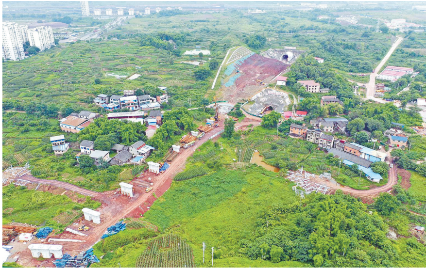
▲成渝中线高铁科学城站片区。
