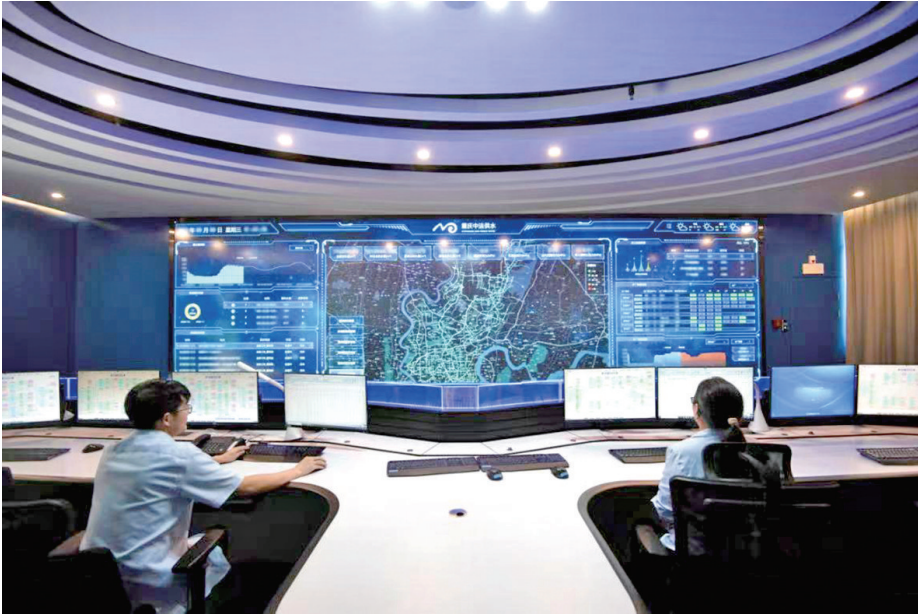
管道修补现场中法供水后台数据控制中心。
