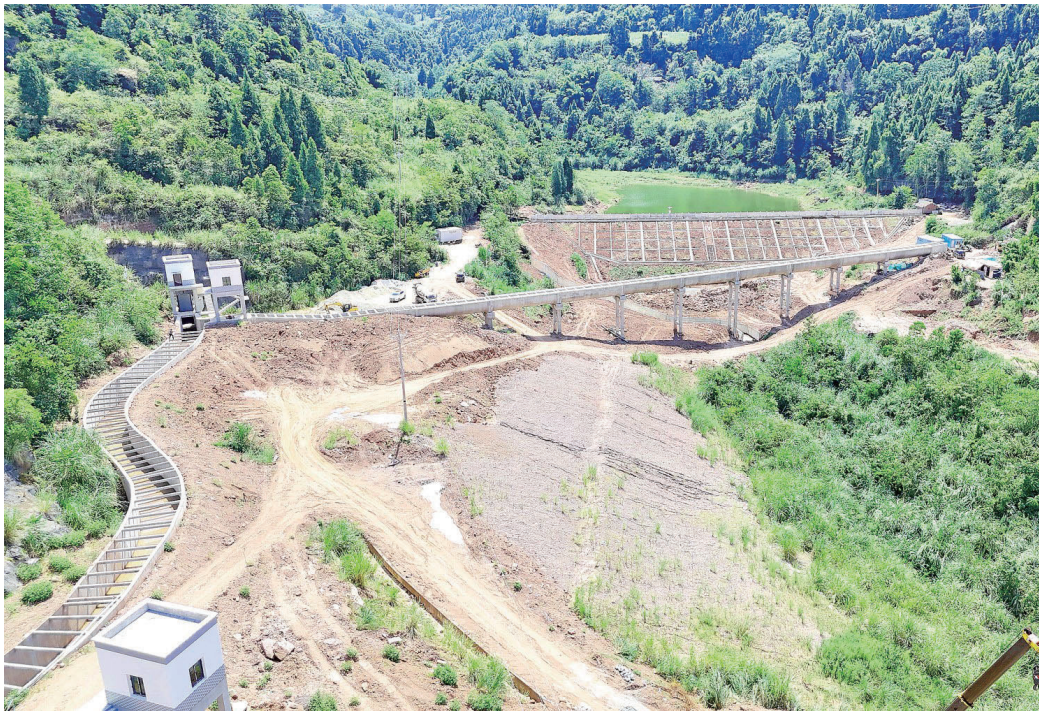
“水到蓬南”渠系工程建成通水。
