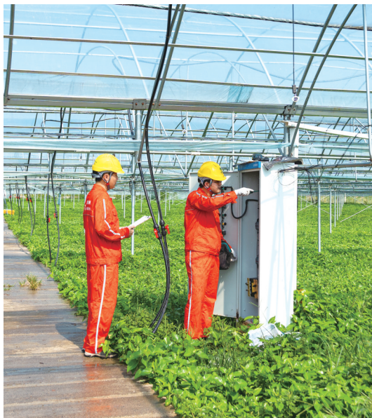
电力员工检修喷淋用电线路。
