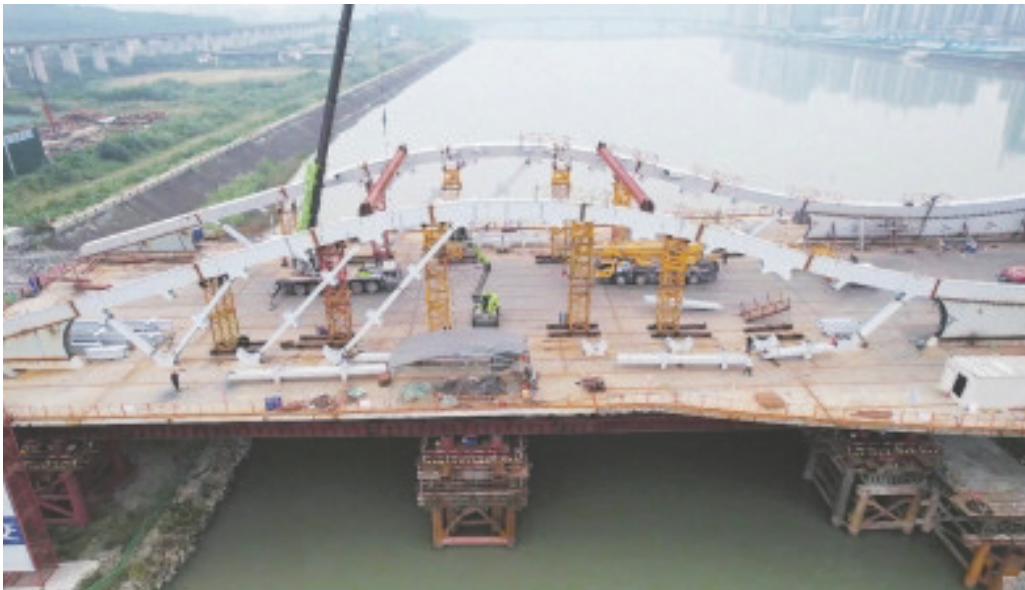
项目现场正在进行主桥刚性吊杆安装
