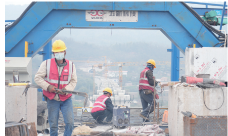
▲工人在施工现场忙碌。
