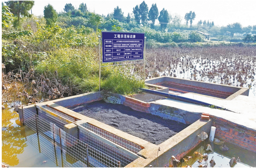
鱼塘尾水治理设施。
