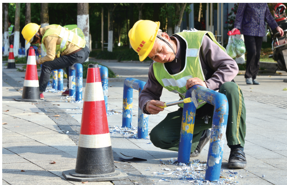
工人维修U型桩。
