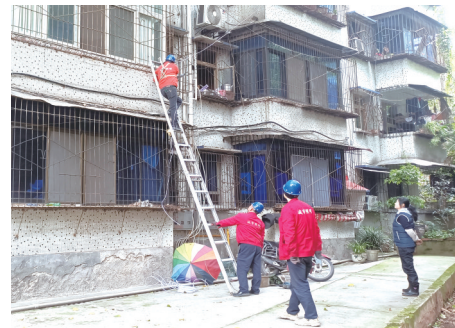
区域管局工作人员给社区安装路灯。
