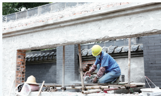
工人们正在北山社区公园施工现场忙碌。
