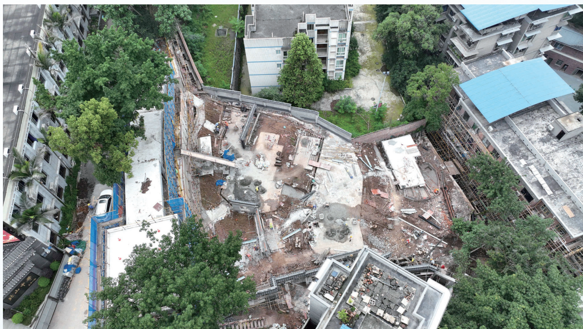
北山社区公园施工现场航拍图。
