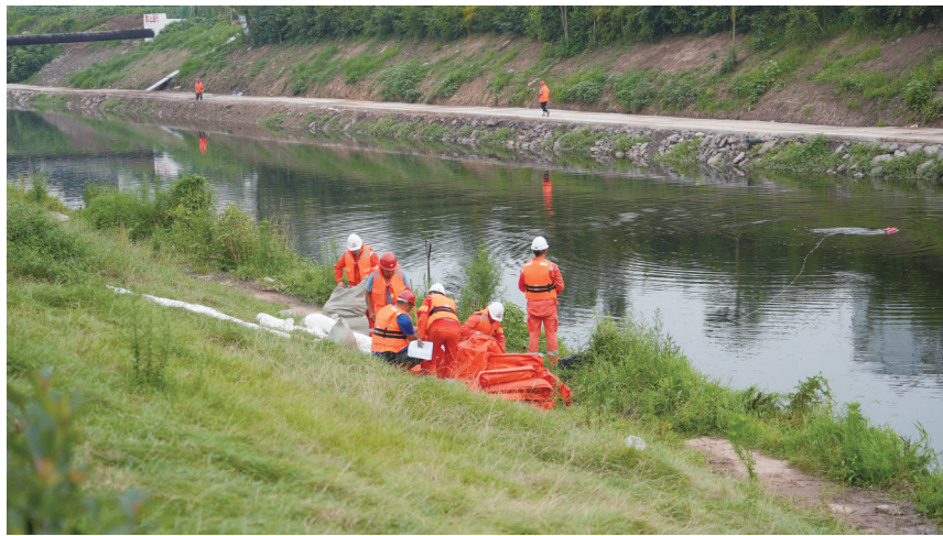
图为应急抢险队员正在铺设围油栏。
