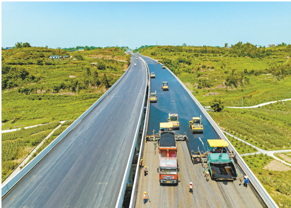
江沪北线高速沥青摊铺现场
