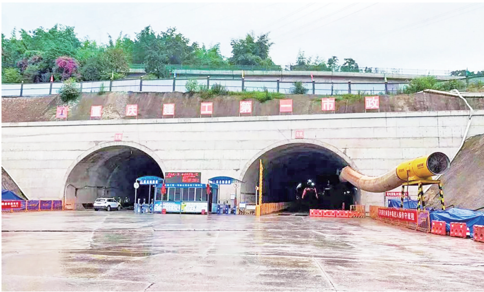
合悦路隧道实现全线贯通
