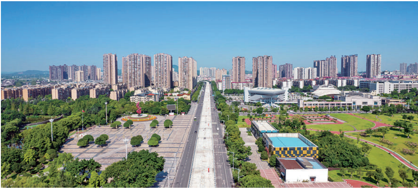
建设中的璧铜线铜梁城区段。
