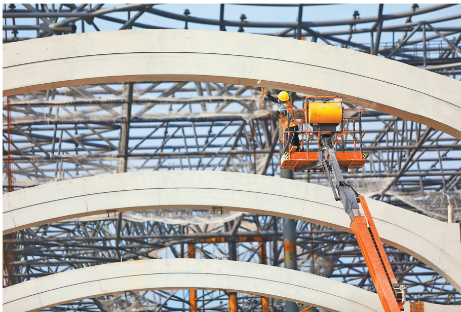
八月一日,重庆东站施工现场,技术工人奋战一线。
