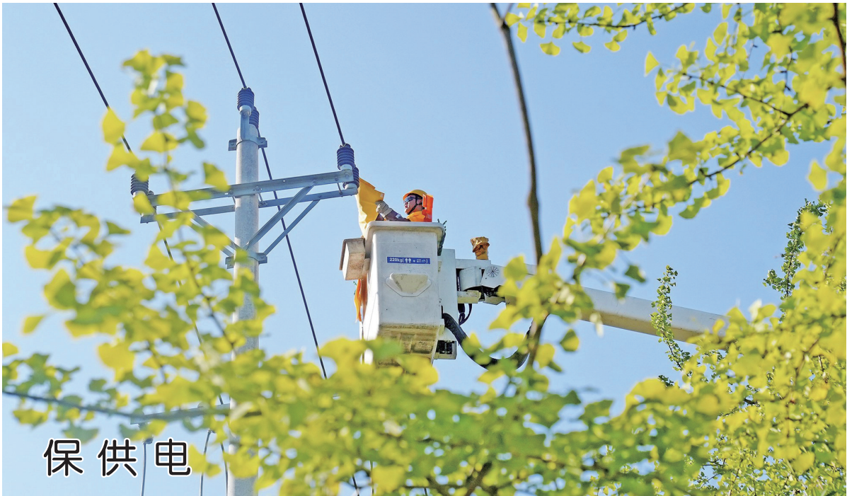
合川供电公司立足自身职能职责,充分利用带电作业方式,持续提高带电作业在配网工程建设、设备消缺、故障抢修、用户业扩等项目覆盖率。 图为近日合川供电公司工作人员在10千伏尊望线3号杆带电作业。 合川报记者 任洋 通讯员 秦晓东 摄 据《合川报》
