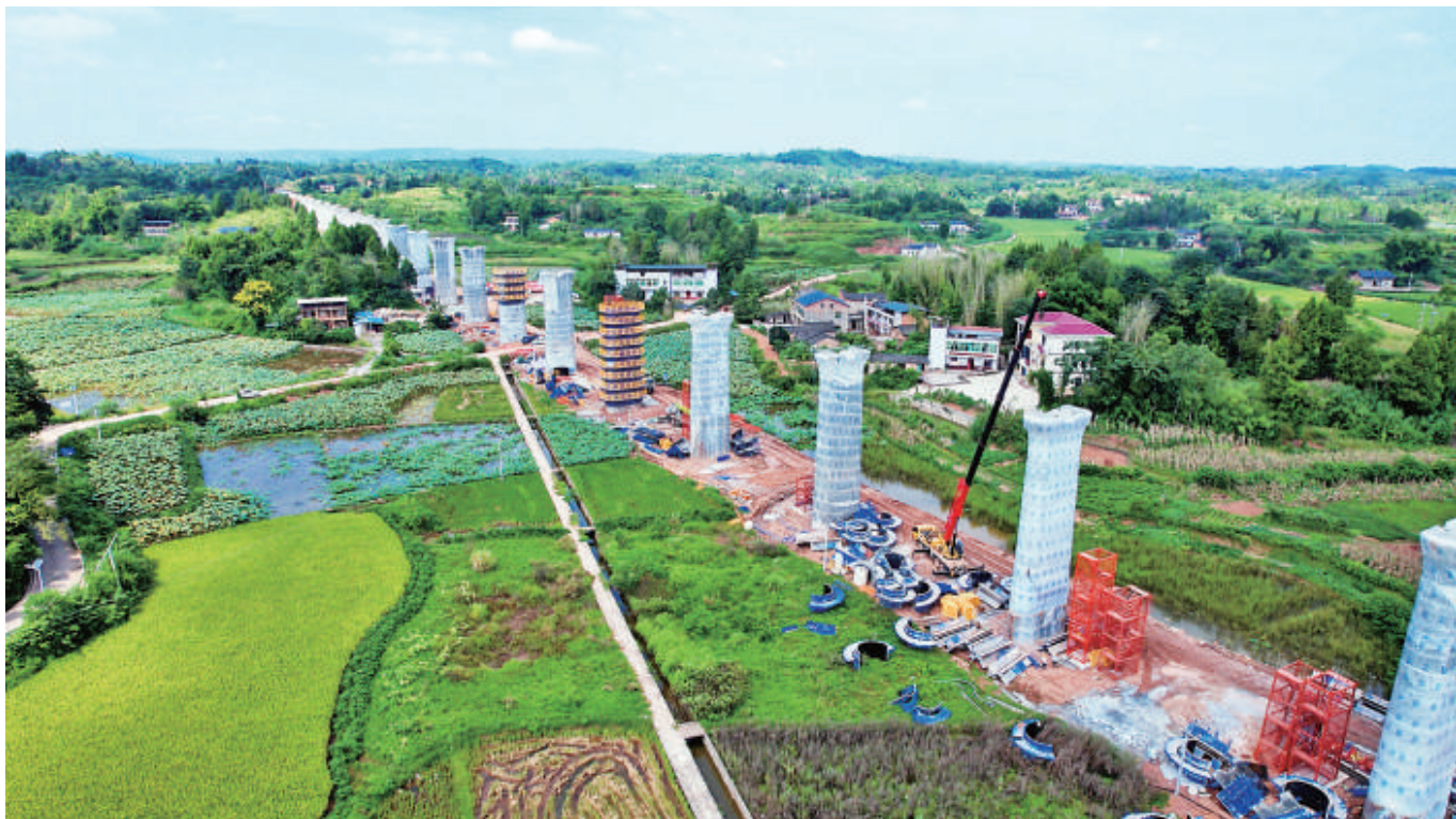
成渝中线高铁土桥枢纽互通双线特大桥建设现场。 铜梁报记者 张峰 摄
