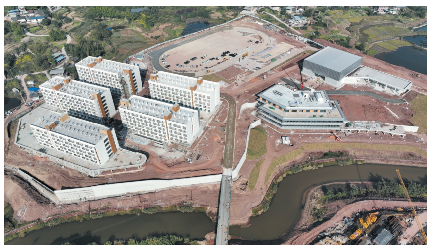
一期工程建设现场。
