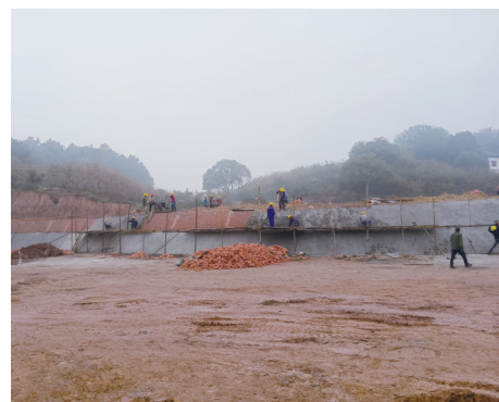
图为建设现场。
