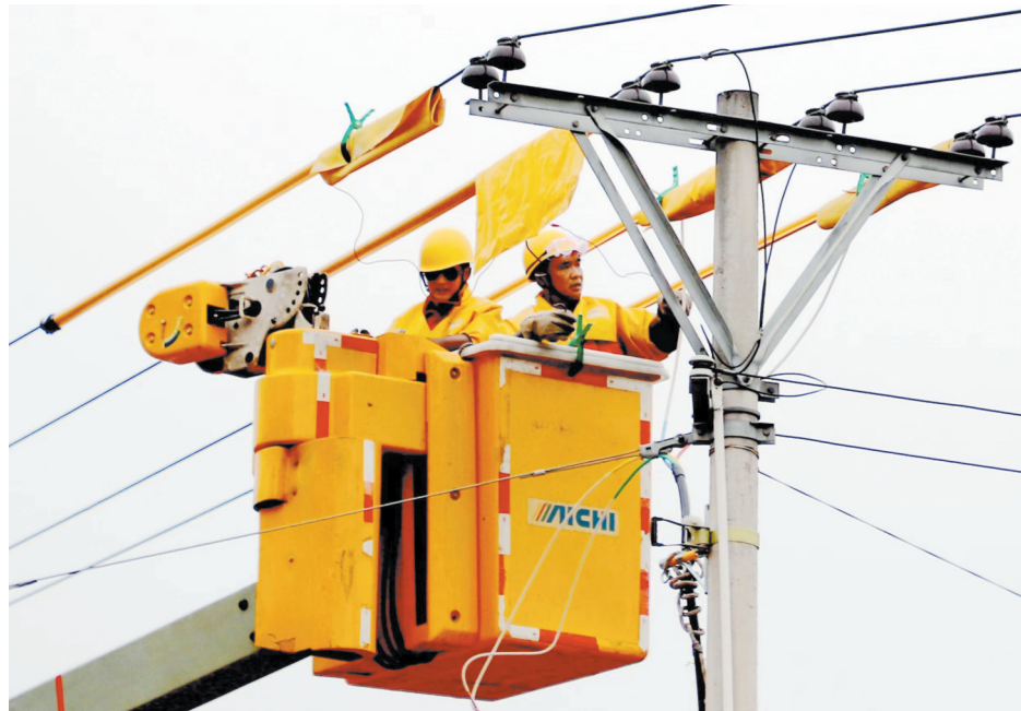
国网重庆永川供电公司带电作业班人员在进行带电拆除作业。
