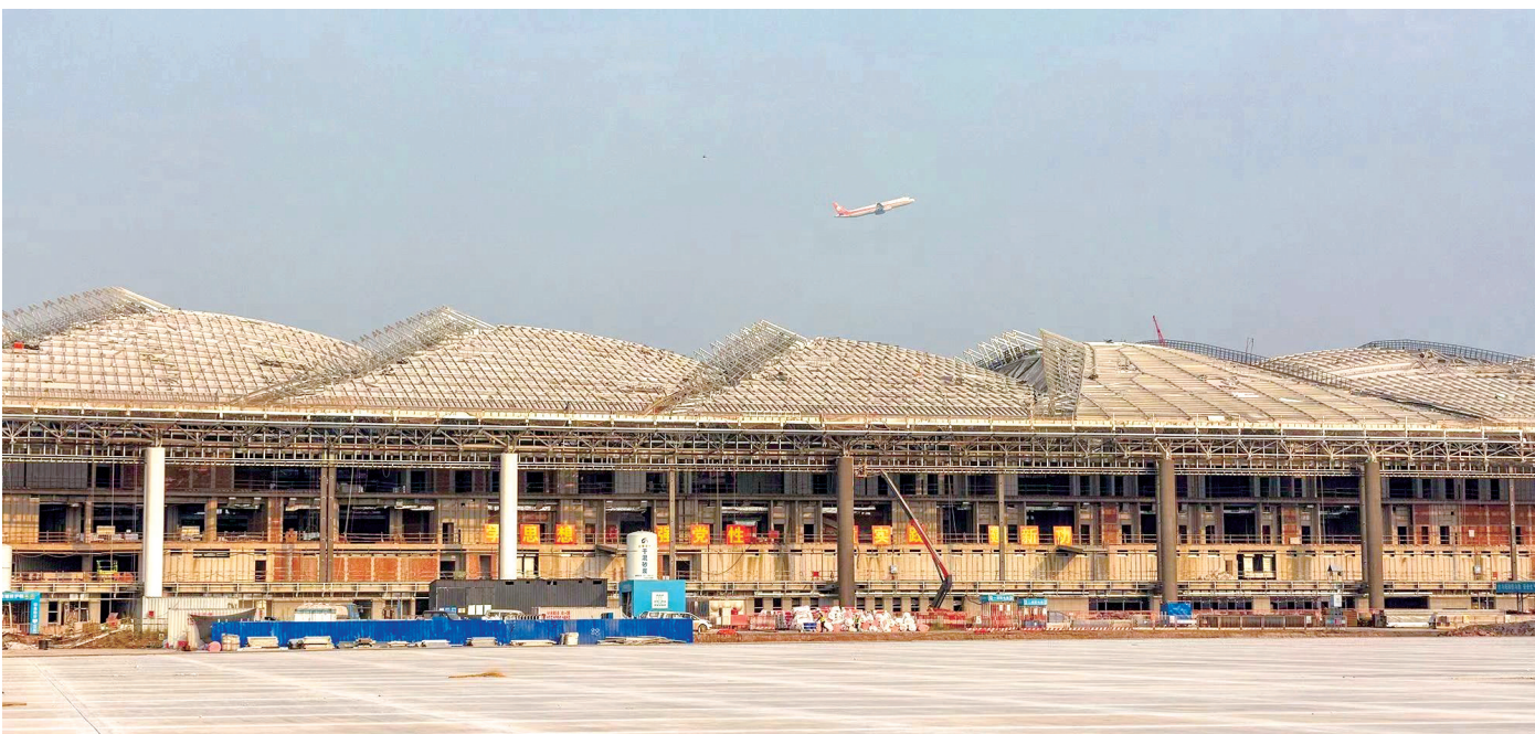
重庆江北国际机场T3B航站楼施工现场
