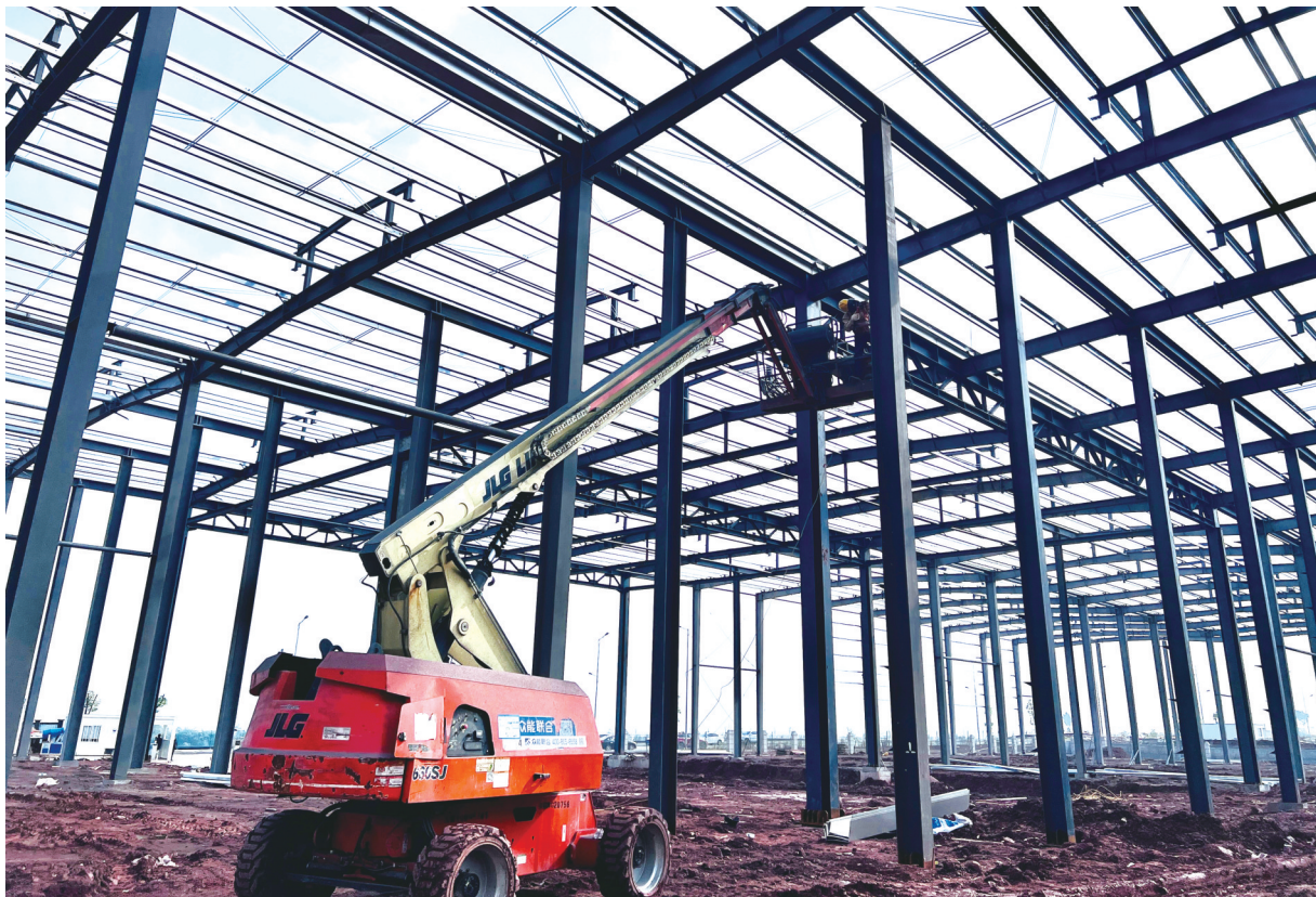
焊接厂房钢结构节点
