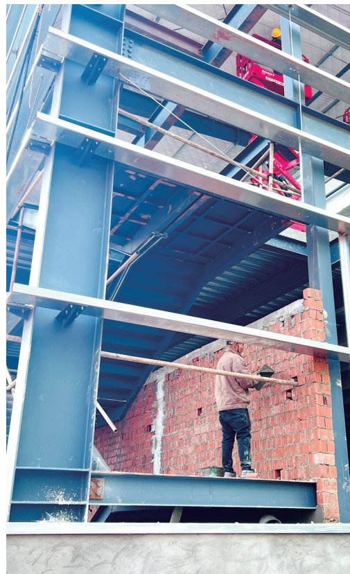
厂房墙面砌筑作业
