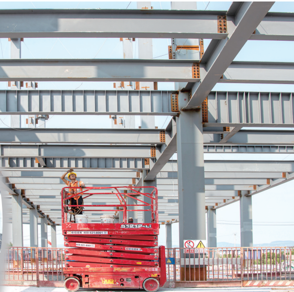
工人检查旅客中心钢结构安装情况
