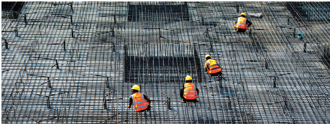
工人进行地下室底板钢筋绑扎
