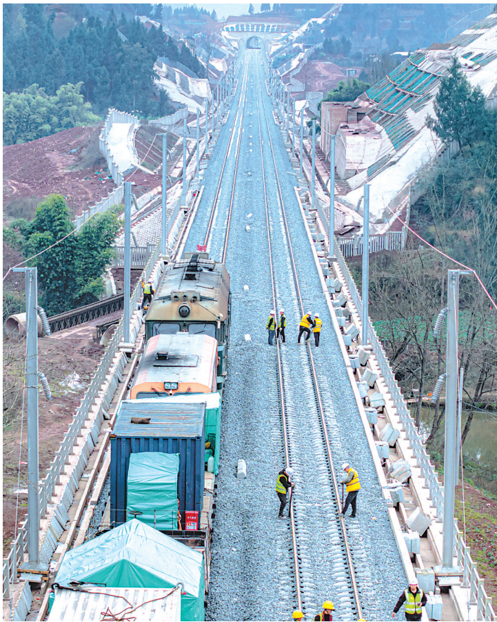
巴南高铁顺庆段铺轨作业施工现场
