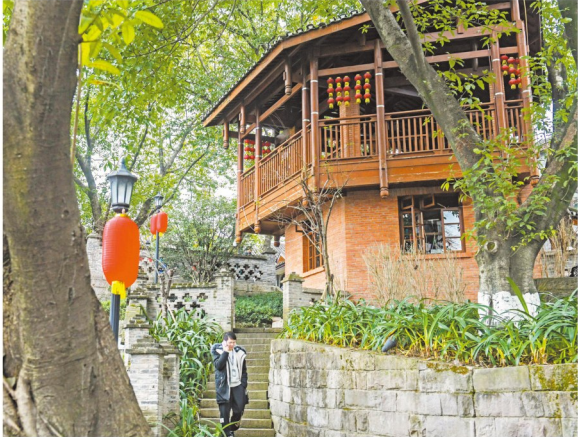
重庆日报记者张锦辉摄/视觉重庆 是由危旧房改造而成的。 一月二十四日，渝中区马鞍山传统风貌区，供游客登高远眺的仿古建筑观堂阁引来游客参观。
