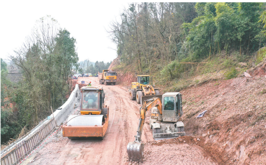
龙万路施工现场。
