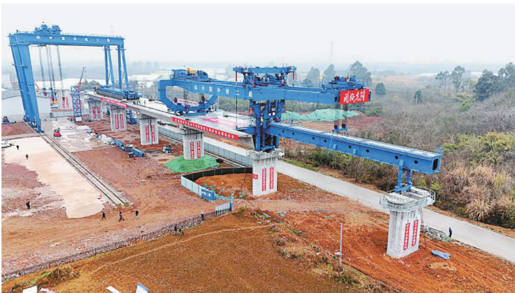
成渝中线高铁首孔箱梁架设现场。
