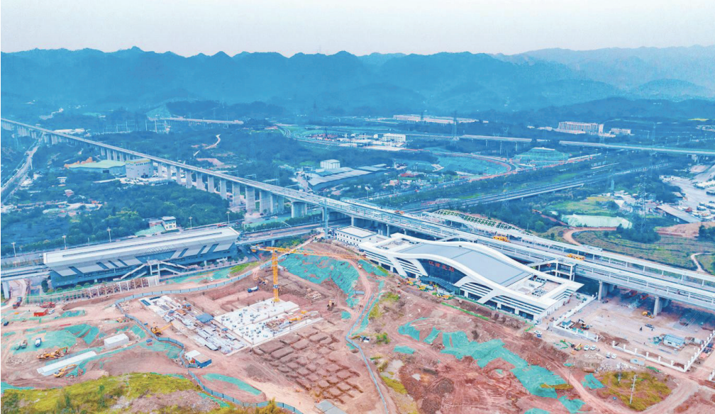
渝昆高铁江津北站建设现场
