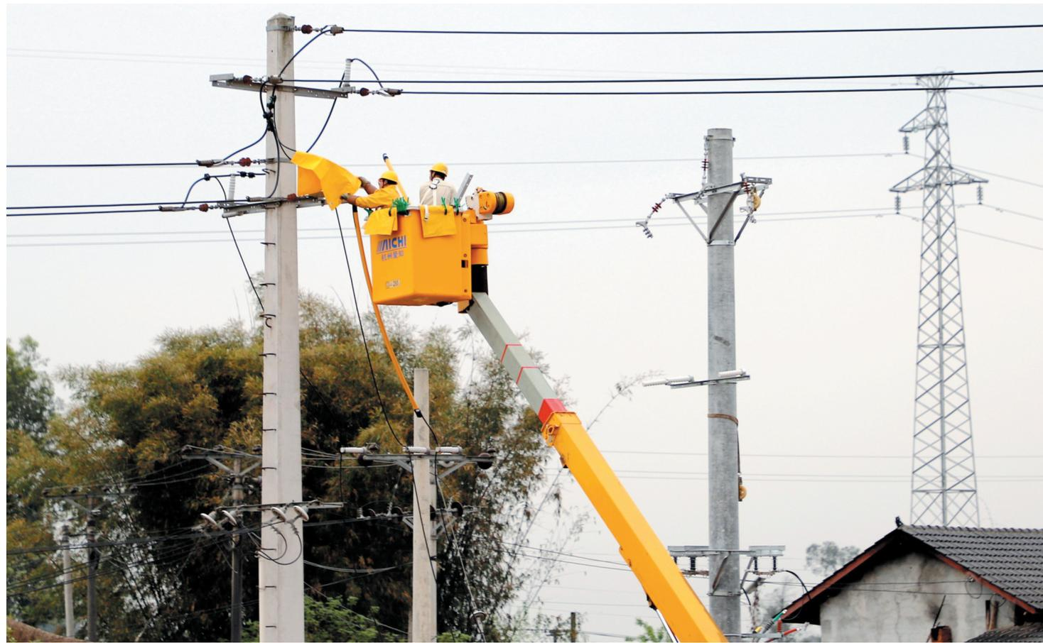
电力工人正在做带电立杆前的绝缘准备。
