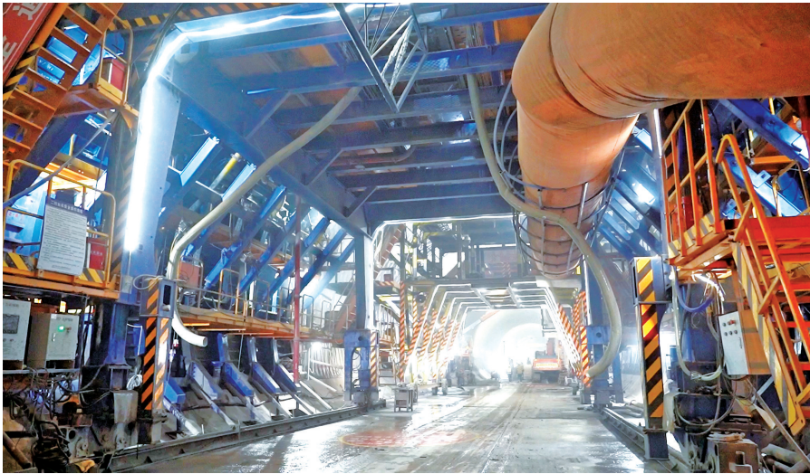
成渝中线高铁高峰村隧道建设现场。
