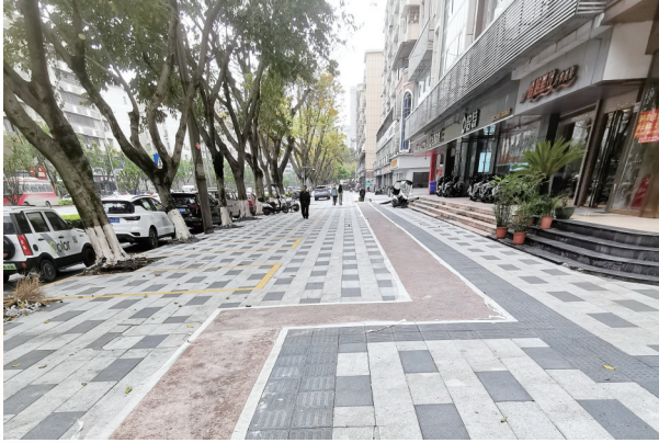
路面改造完成的萱花路
