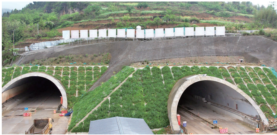
云雾山1号隧道左右双洞全部贯通。
