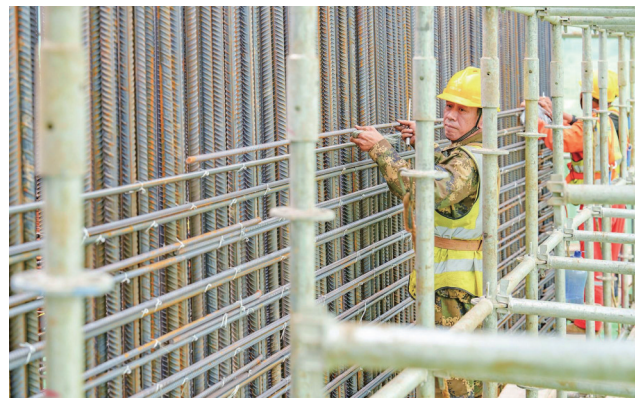
中交二航局的施工人员在绑扎主墩钢筋。
