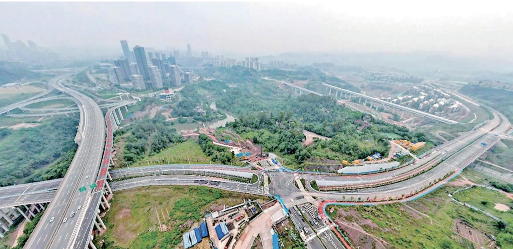
施工现场航拍
