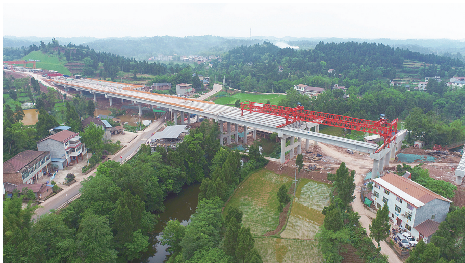
建设中的铜资高速龙台河大桥。
