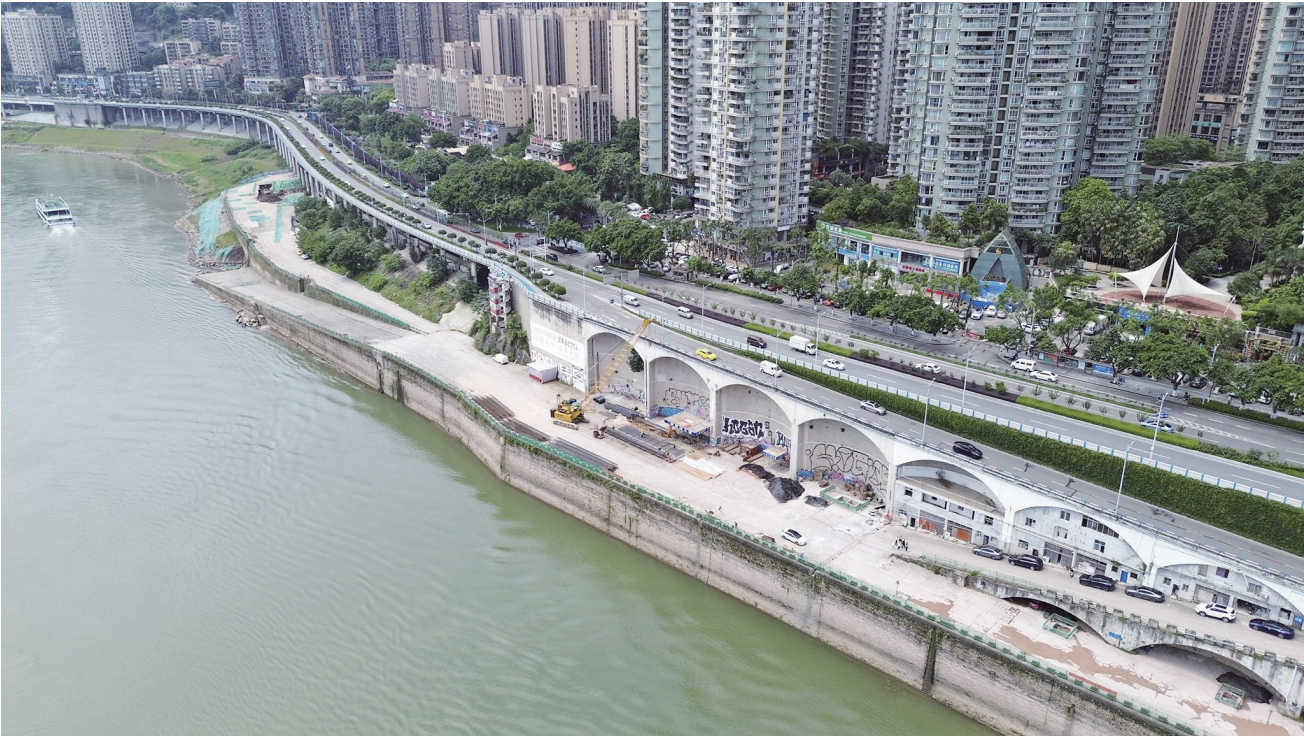
滴水岩至磁器口段(中渡口码头)抓紧施工。
