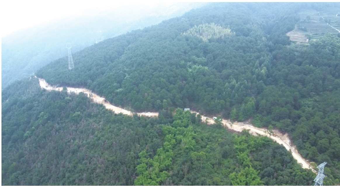
俯瞰永川区重点区域森林草原防火通道建设项目现场。
